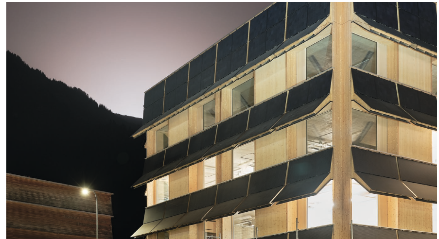
Photo: Unterwerk Stenna (top); Verkehrsstützpunkt Kapo Chur (bottom). Credits: Yufei He / BUK ETHZ
