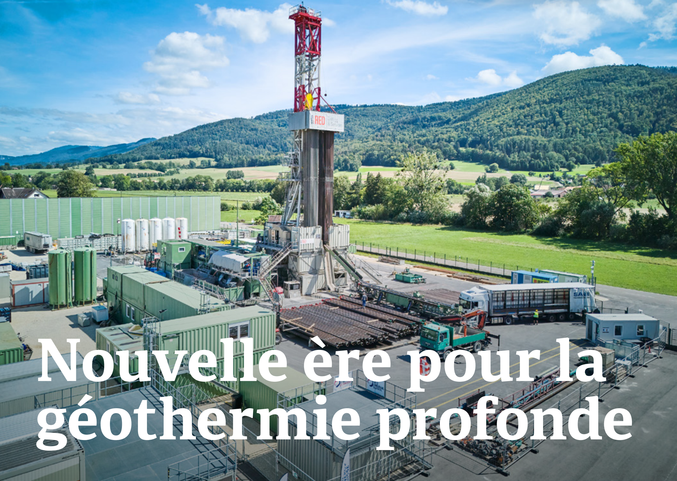
Le site de forage géothermique à Haute-Sorne (JU) ressemble à un grand chantier.
