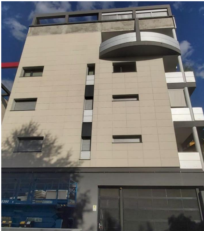
Figure Errore. Nel documento non esiste testo dello stile specificato. Façade after the removal of the top three rows of conventional PIZ H89 panel
