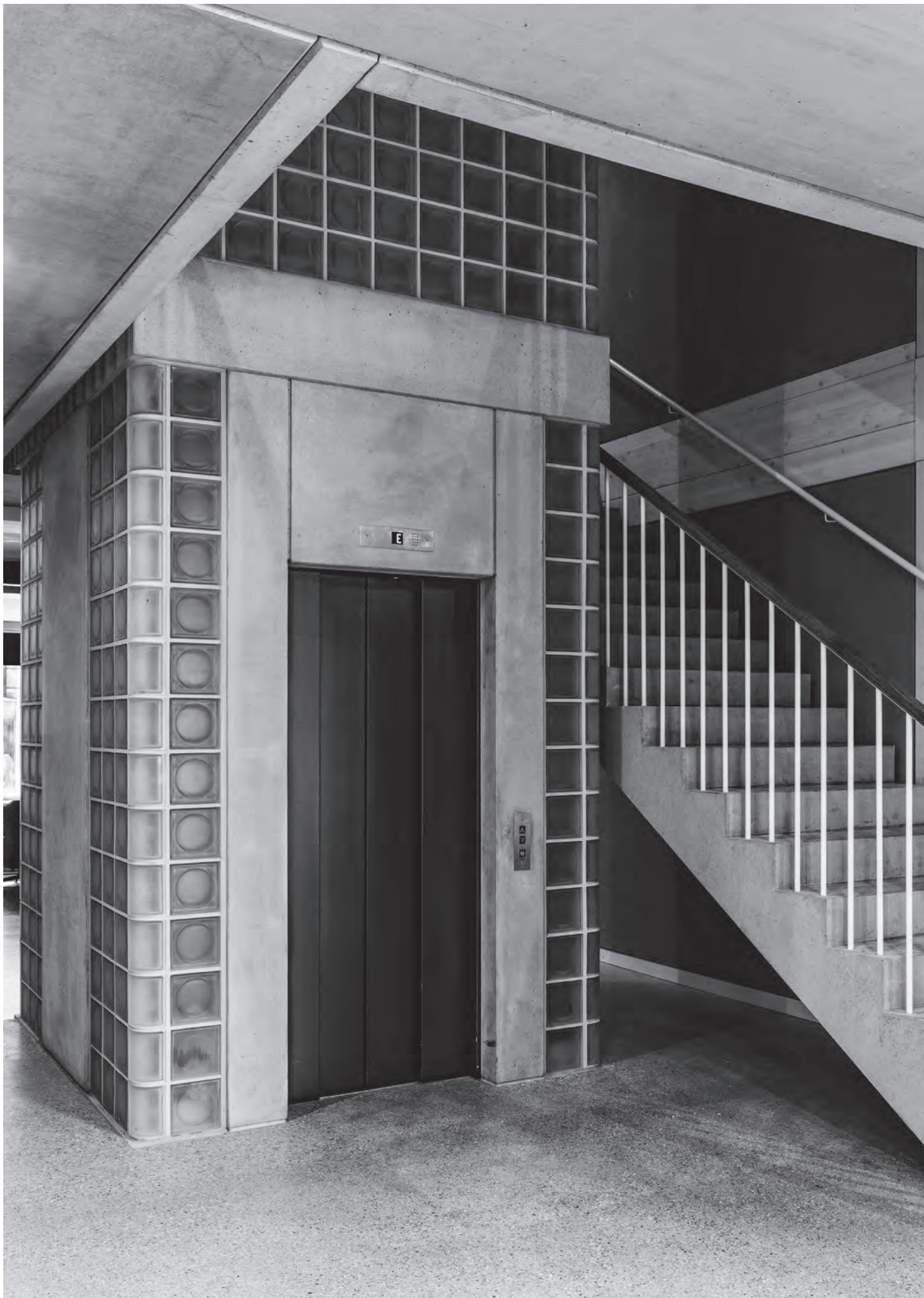
Il vano dell'ascensore, situato nella tromba delle scale, con le pareti di mattonelle in vetrocemento.
