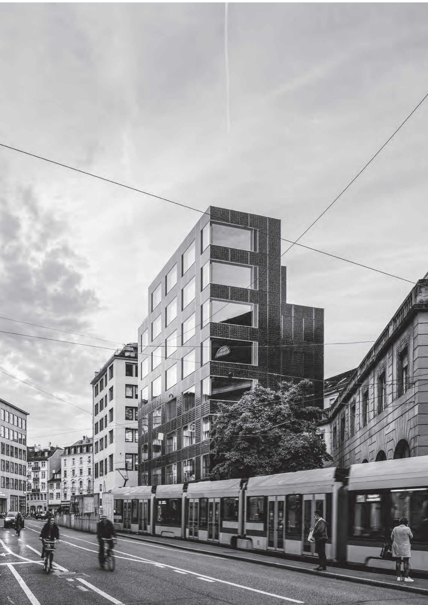
Visto dal mercato ittico, il nuovo edificio dell'UAE, l'Ufficio cantonale dell'ambiente e dell'energia, si presenta slanciato ed elegante.
