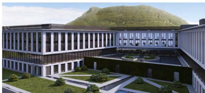
Le facciate sono costituite da moduli fotovoltaici intercalati a serramenti d'alluminio.
