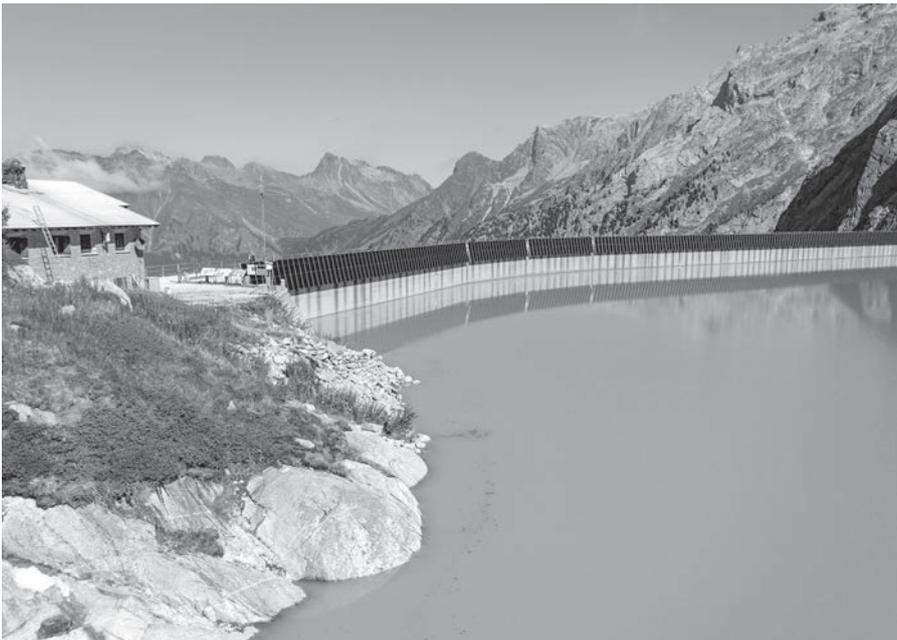
**Fotovoltaico sul muro
