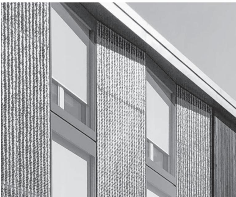
Dietro la struttura stampata traspiega gli elementi conduttori dei moduli fotovoltaici.
