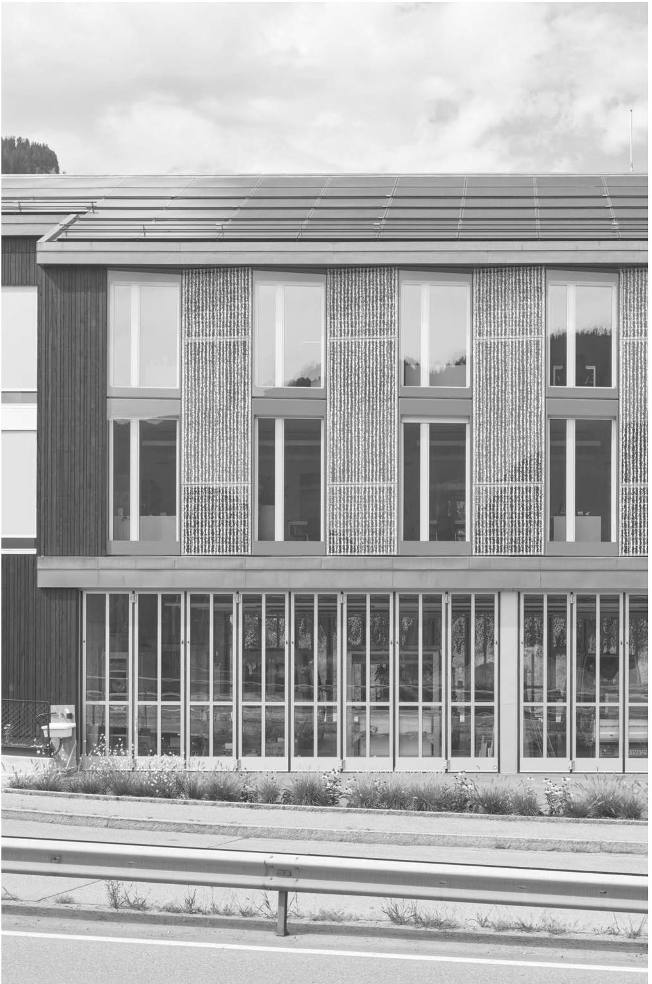
Photovoltaïque à deux niveaux: discrètement sur le toit, en décoration entre les fenêtres.
