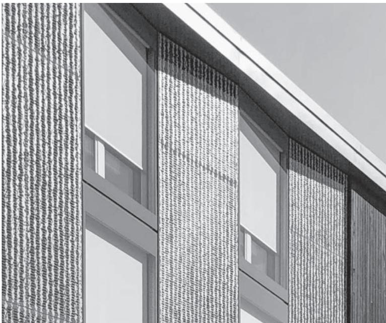
Les pistes conductrices des modules photovoltaïques transparentent derrière la structure imprimée. Photo: Büro Krucker
