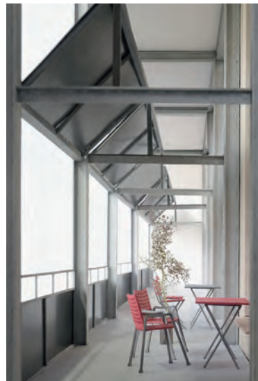
À la fois les brise-soleil inclinés et les parapets des balcons produisent de l'électricité.
