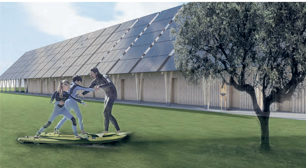
Sonnenstrom als Zeichen: Die filigrane Dachkonstruktion trägt eine Solaranlage als Dachhaut.
