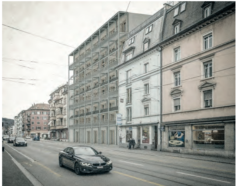
Das Haus mit «Filter» an der vielbefahrenen Birmensdorferstrasse in Zürich.
