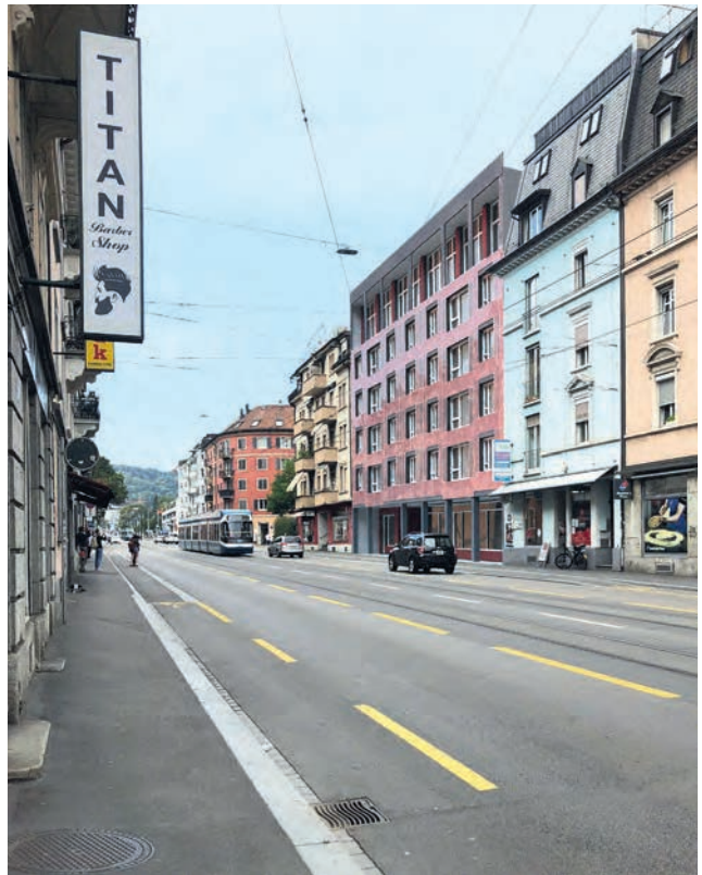
Eine kräftig-farbige Solarfassade.
